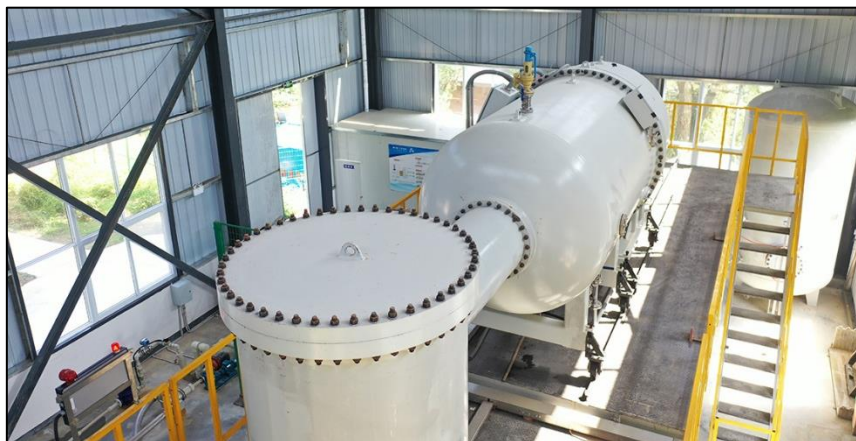
Figura 10. Acelerador de electrones autoblandado utilizado para irradiar efluentes médicos. Fuente: (Liou J., 2021)
