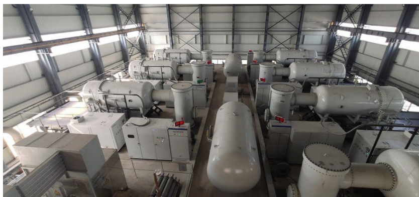
Figura 8. Planta de irradiación de efluentes industriales con e-beam. Fuente: (Liou C. W., 2021)
