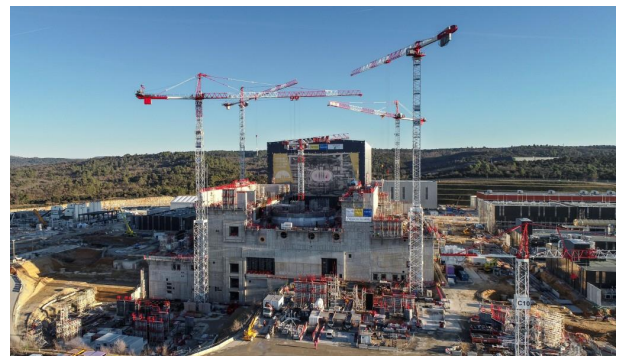
(d) Obra civil. Vista frontal del edificio del tokamak ITER.
