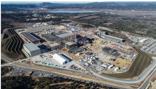
(a) Perspectiva del predio designado para la construcción del proyecto ITER.
